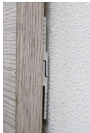
**Suporte de alumínio para fixação de painéis.**
